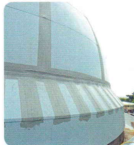
Die Bausubstanz der Kuppel wurde mit Triflex Metal Coat geschützt.
