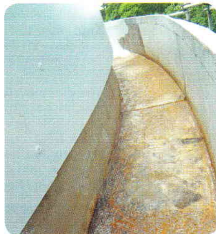
Sowohl Details als auch die große Dachfläche wurden mit Triflex abdichtetet.
